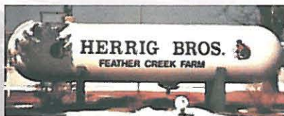
Tanque de Herrig antes de la explosión
